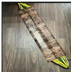
⑤事務所席替え等で、複合機の配線がむき出しの状態が続いていた。配線カバーにシールを貼り、床に固定したことで足元がスッキリした。by斎藤裕子・鮑辰霖
